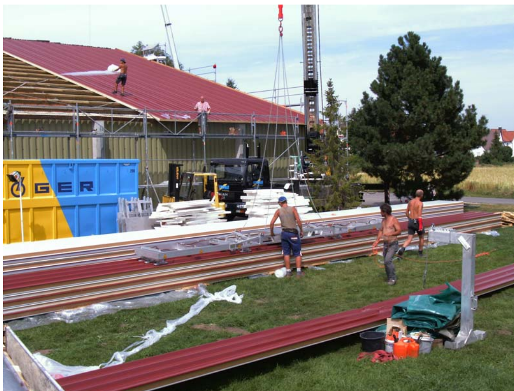
Mitarbeiter der Burgauer Fa. Stehle beim Verlegen der über 30m langen „Sandwichplatten“
