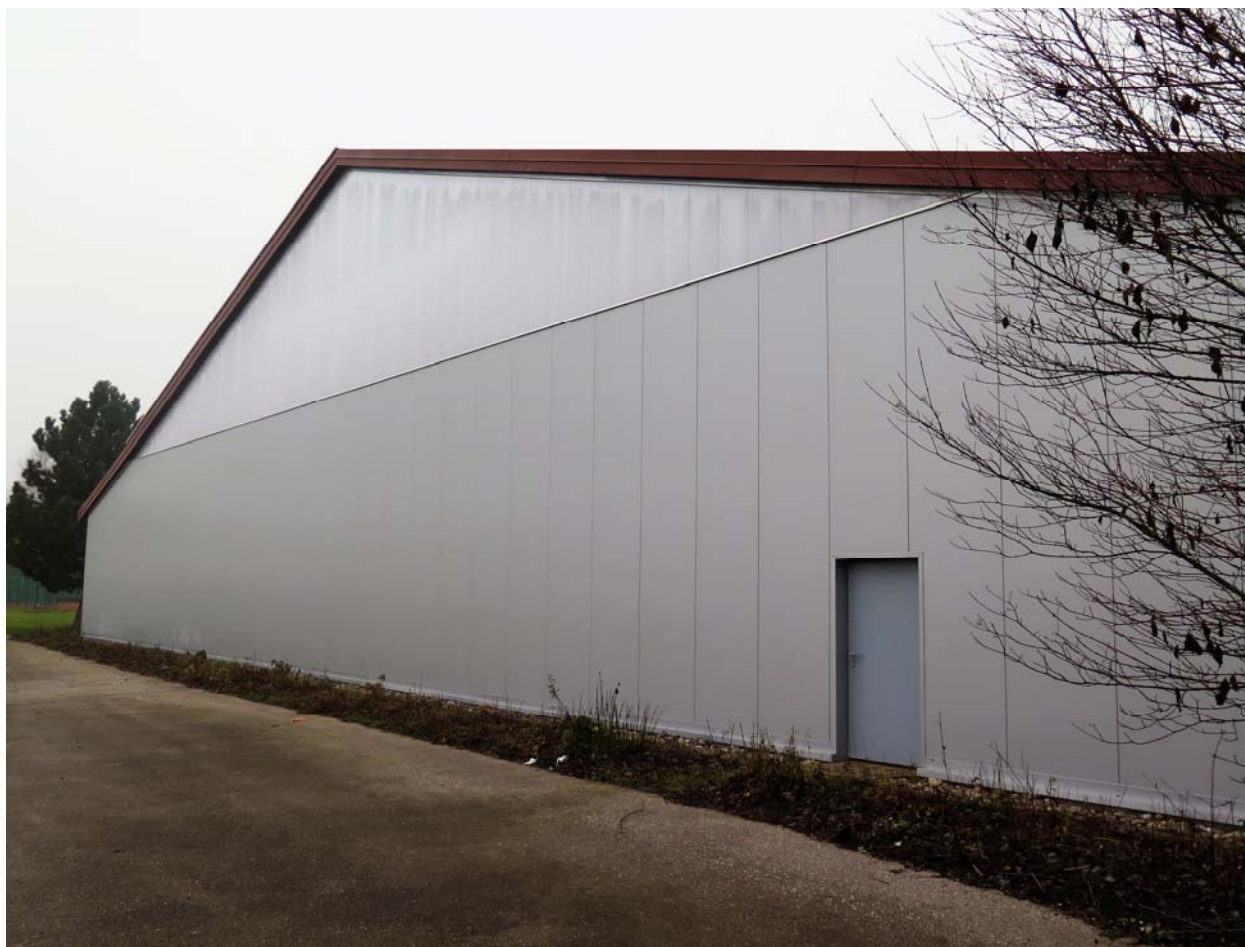
Hallenostseite nach der Renovierung im Oktober 2015
