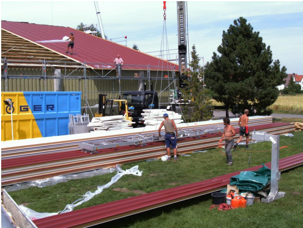
Mitarbeiter der Burgauer Fa. Stehle beim Verlegen der über 30m langen „Sandwichplatten“
